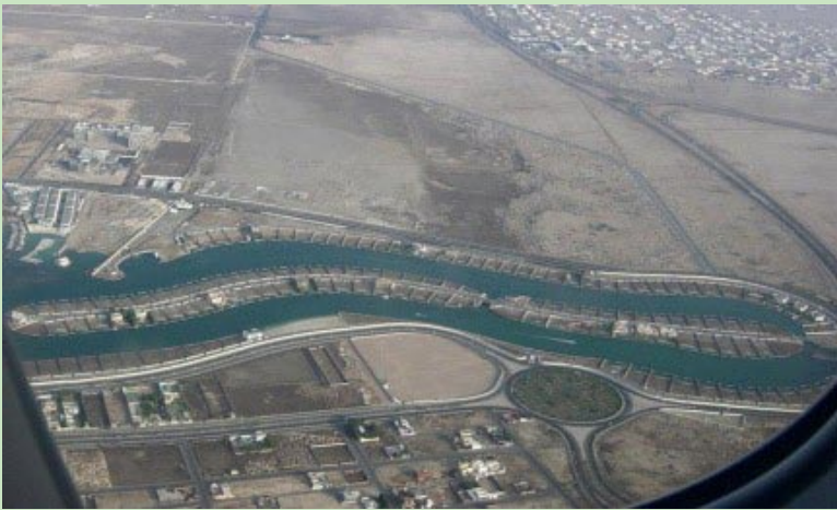
Obhur河项目，吉达，沙特阿拉伯 总体方案和住宅设计（左）建成项目（右）（合乐） Obhur Creek Jeddah, Saudi Arabia. Master Plan model and housing designs- left, and implemented project –right (Halcrow)
